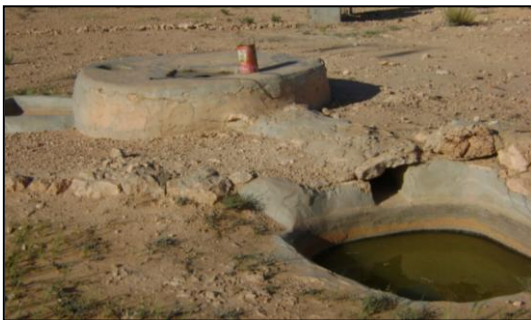
Photo 4: Citerne pour la collecte des eaux pluviales pour l'abreuvement du cheptel. Sidi Bouzid
