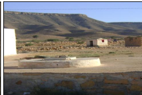
Photo 6: Citerne pour la collecte des eaux pluviales pour l'alimentation en eaux potable de Ksar Jedid – Médenine
