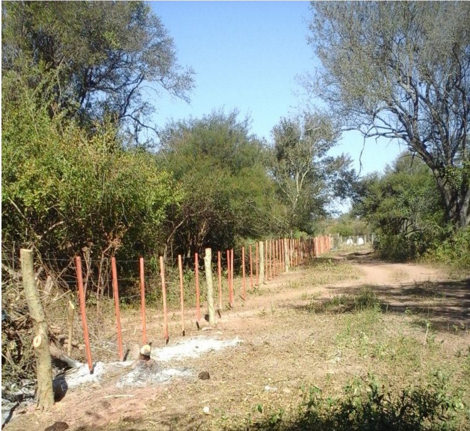
Foto 9. Cerco construido y deschampado en el Puesto de La Soledad. Foto Cristina Camardelli
