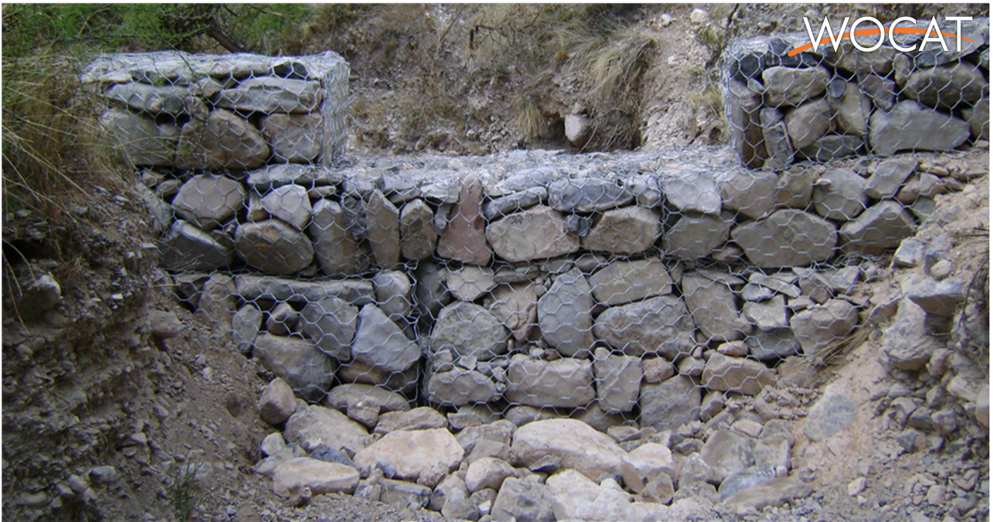
Presa de sedimentación, fotografía tomada en el Cantón de Nabon, Provincia de Azuay, Ecuador (FAO ECUADOR y Ministerio del Ambiente ECUADOR) (Luis Diaz, consultor DS-SLM ECUADOR)
