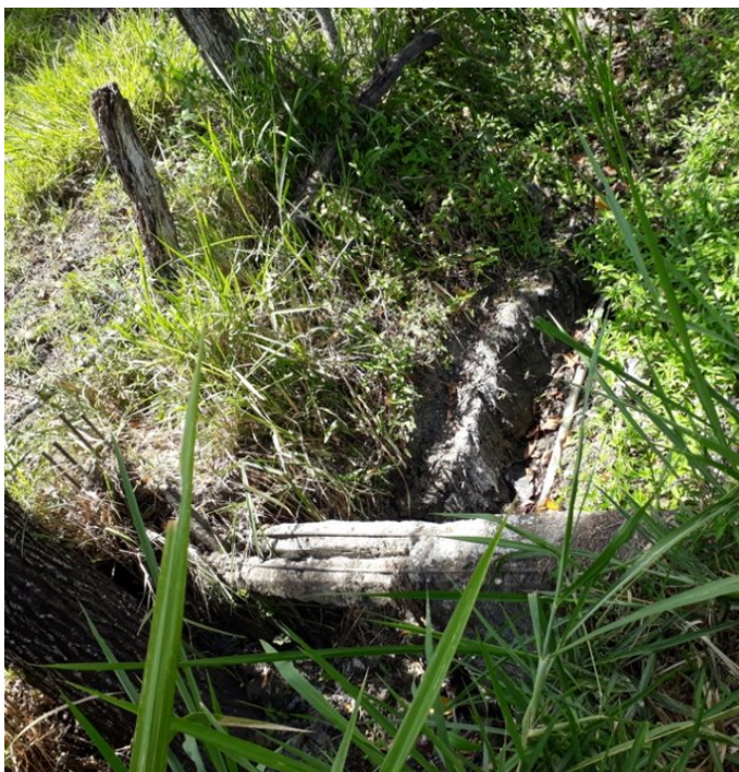
Muro de contención de agua, Parroquia de Nambacola, Cantón de Gonzanama, Provincia de Loja, (Luis Diaz, consultor DS-SLM ECUADOR)
