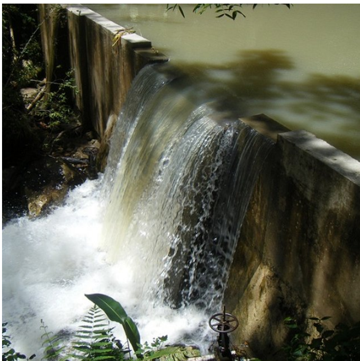
Presa de sedimentación, Cantón de Nabon, Provincia del Azuay, Ecuador (Luis Diaz, consultor DS-SLM ECUADOR)
