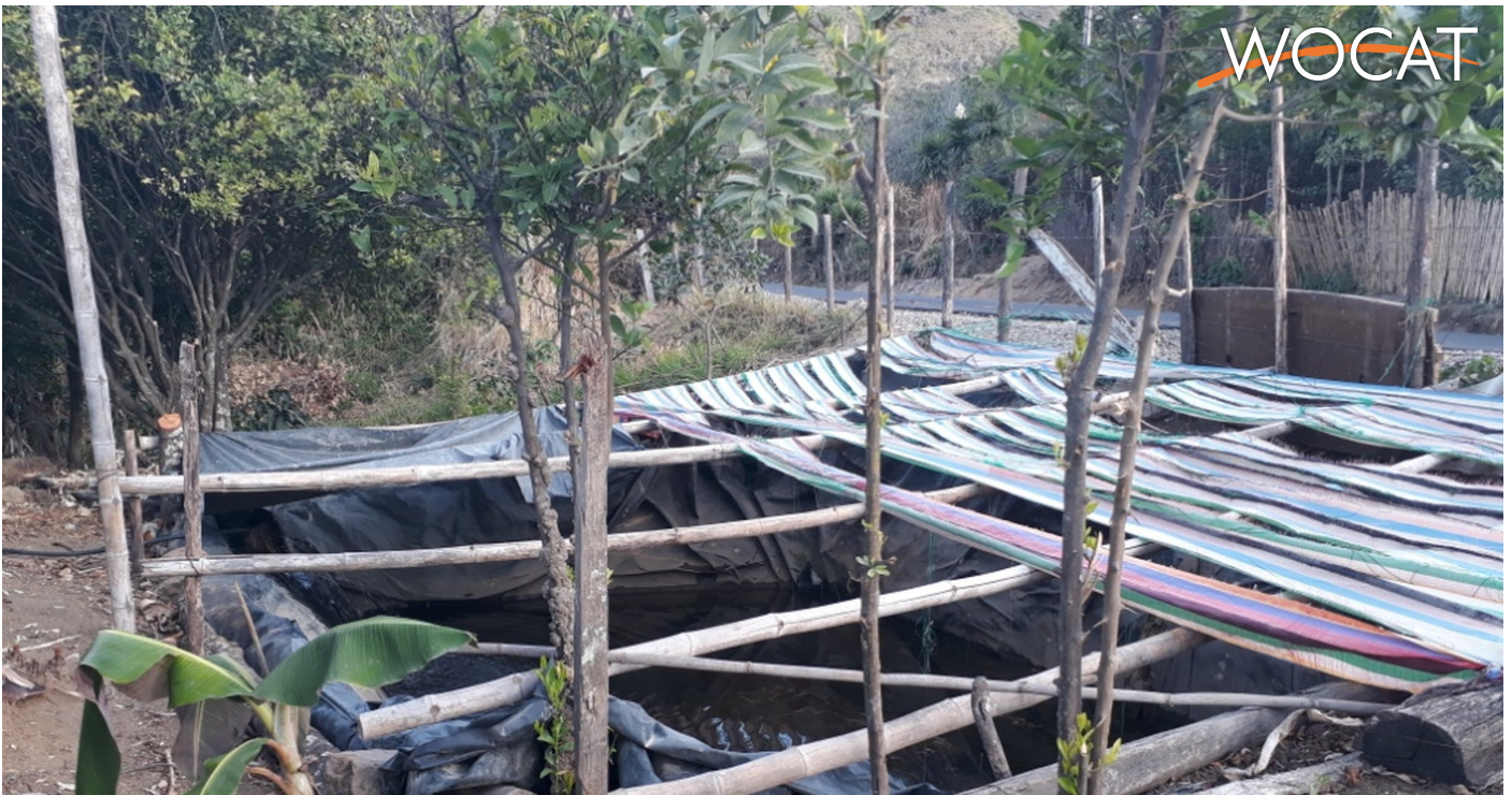
Reservorio familiar de agua, con geomembrana, fotografía tomada en la Parroquia de Nambacola, Provincia de Loja, Ecuador (FAO ECUADOR y Ministerio del Ambiente ECUADOR) (Luis Diaz, consultor DS-SLM ECUADOR)
