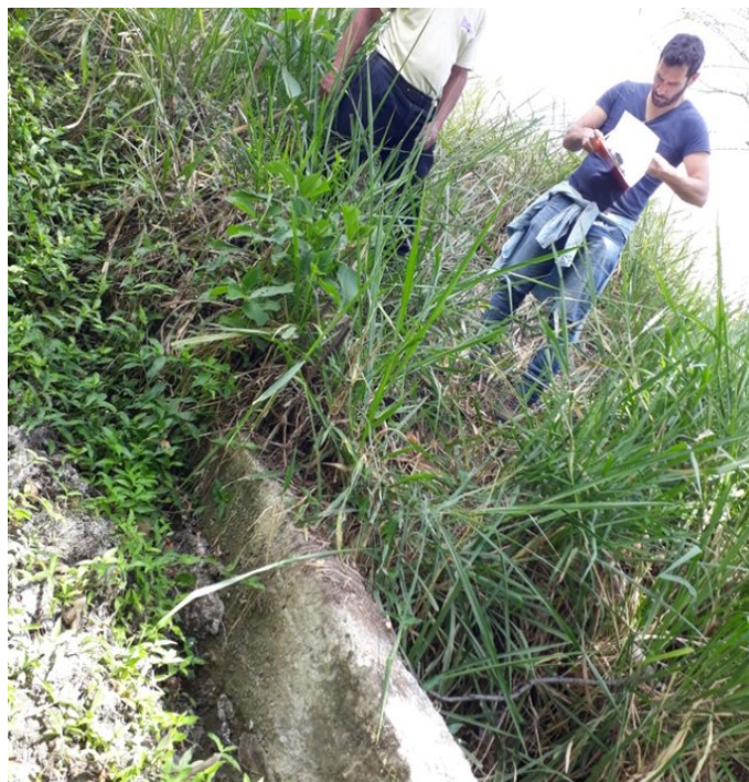
Muro de contención de agua, Parroquia de Nambacola, Cantón de Gonzanama, Provincia de Loja, Ecuador (Luis Diaz, consultor DS-SLM ECUADOR)
