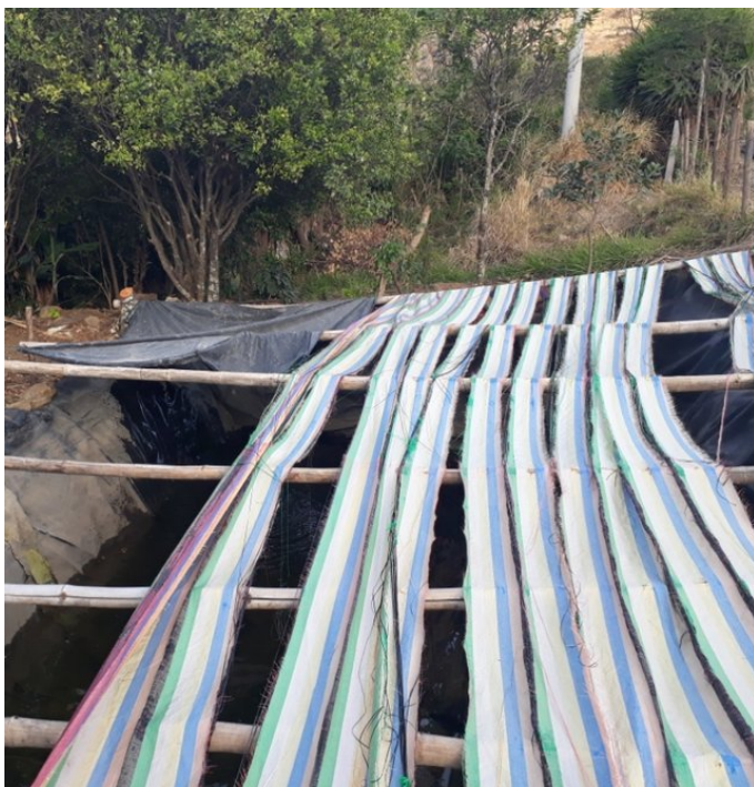
Reservorio de agua familiar con geomembrana, Parroquia de Nambacola, Cantón de Gonzanama, Provincia de Loja, Ecuador (Luis Diaz, consultor DS-SLM ECUADOR)
