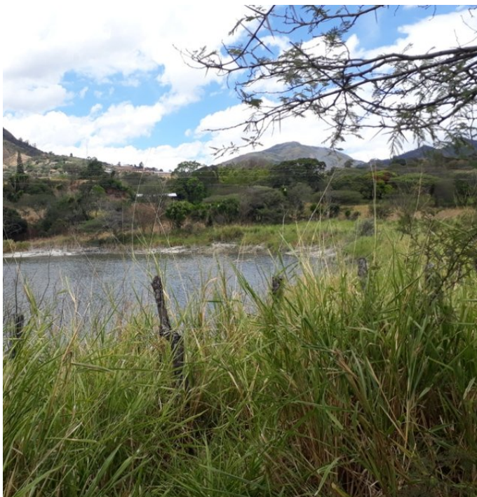
Reservorio comunitario de agua con geomembrana, Parroquia de Nambacola, Cantón de Gonzanama, Provincia de Loja, Ecuador (Luis Diaz, consultor DS-SLM ECUADOR)
